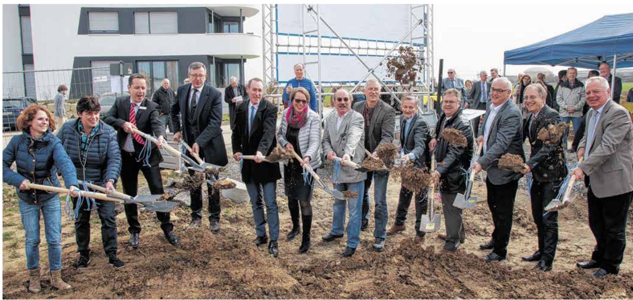
Großes Getümmel beim offiziellen Spatenstich zum neuen Seniorenzentrum und zur neuen Unterkunft der Sozialstation.
